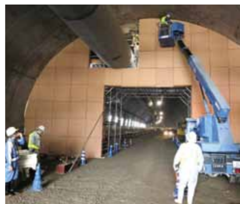
“HiPLE-ACE”应用介绍: 用作隧道施工的挡风板瓦楞纸板可以回收再利用, 相比之前的施工费用可以减少将近一半。如上图长崎县的隧道施工案例。
